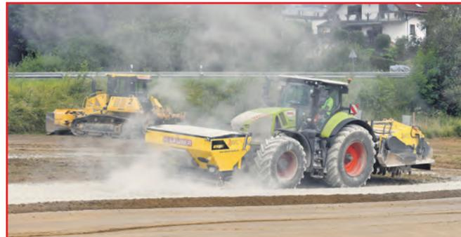
Mit schwerem Gerät wurde der Boden gekalkt und der Kalk anschließend mit einer Fräse eingearbeitet.
