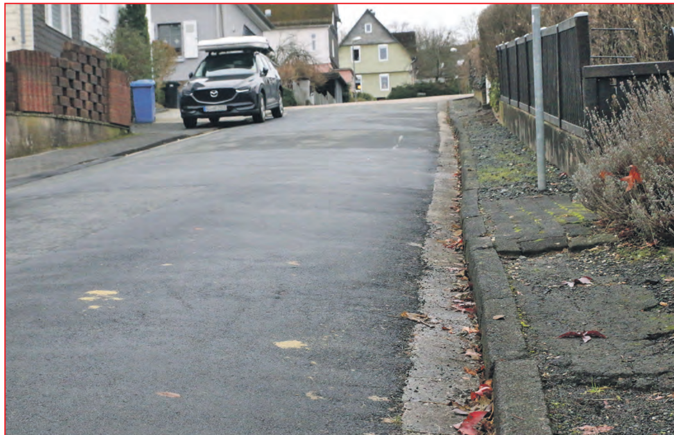
Die Jägerstraße soll in diesem Jahr grundhaft erneuert werden.
