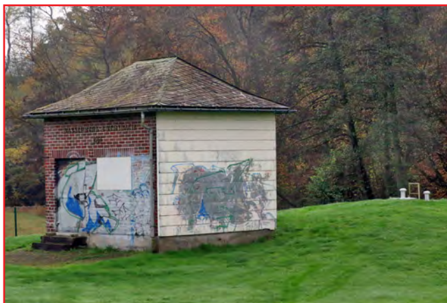
Der Tiefbrunnen Kamp zwischen Ewersbach und Steinbrücken wird als erste Anlage der Wasserversorgung in die neue Fernüberwachung eingebunden.
