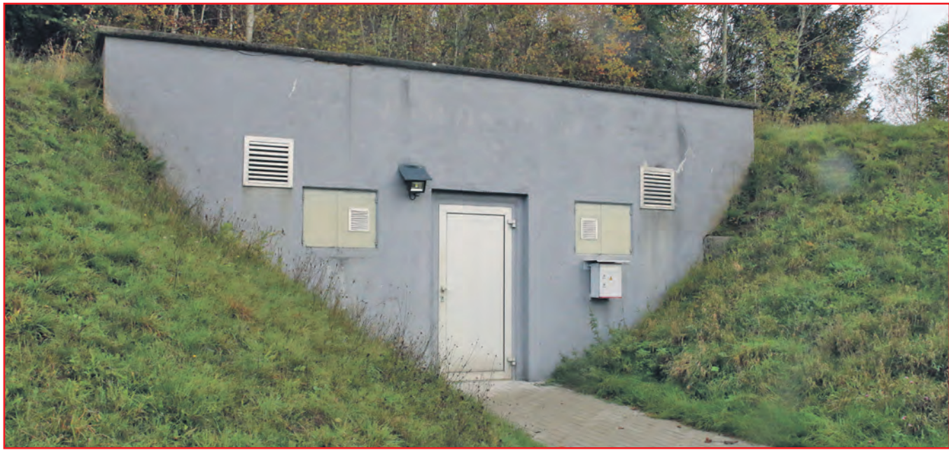
Im Hochbehälter Forst soll im kommenden Jahr die rechte der beiden Kammern saniert werden.
