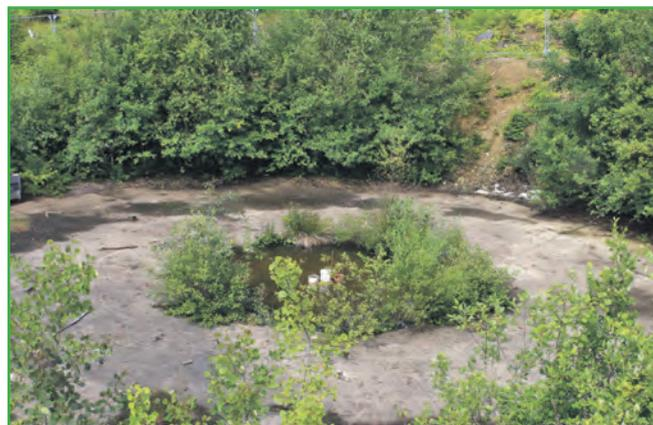
Die alten Fundamente für die Windräder aus dem Jahr 2014 wachsen allmählich zu und sind für die neuen Anlagen zu klein.
